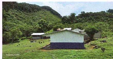
FOTO No. 6 EL TRABAJO HA CONCLUIDO.
