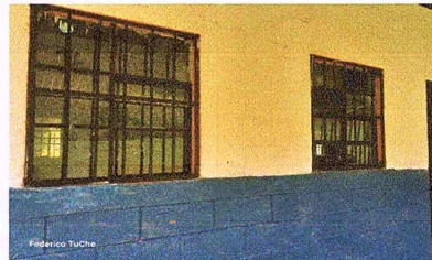
Foto 2: COLOCACION DE BALCONES EN LAS SEIS VENTANAS DEL AULA
