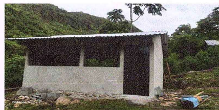
Foto 4: SUSTITUCION DE AREA DE COCINA
